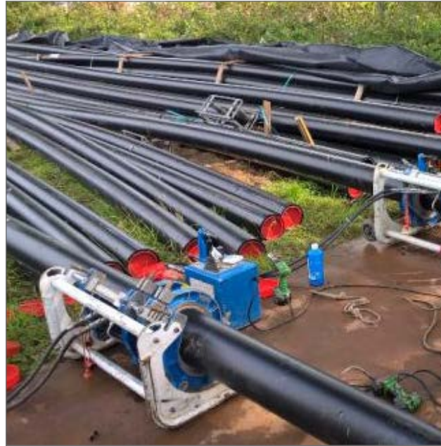
fig. 6 Mantelbuizen op uitleglocaties
