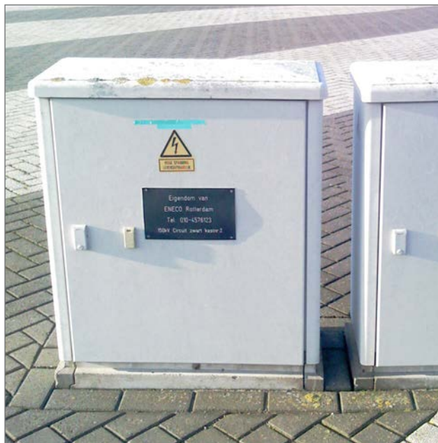
fig. 7 Voorbeeld van een cross-bondingkast
